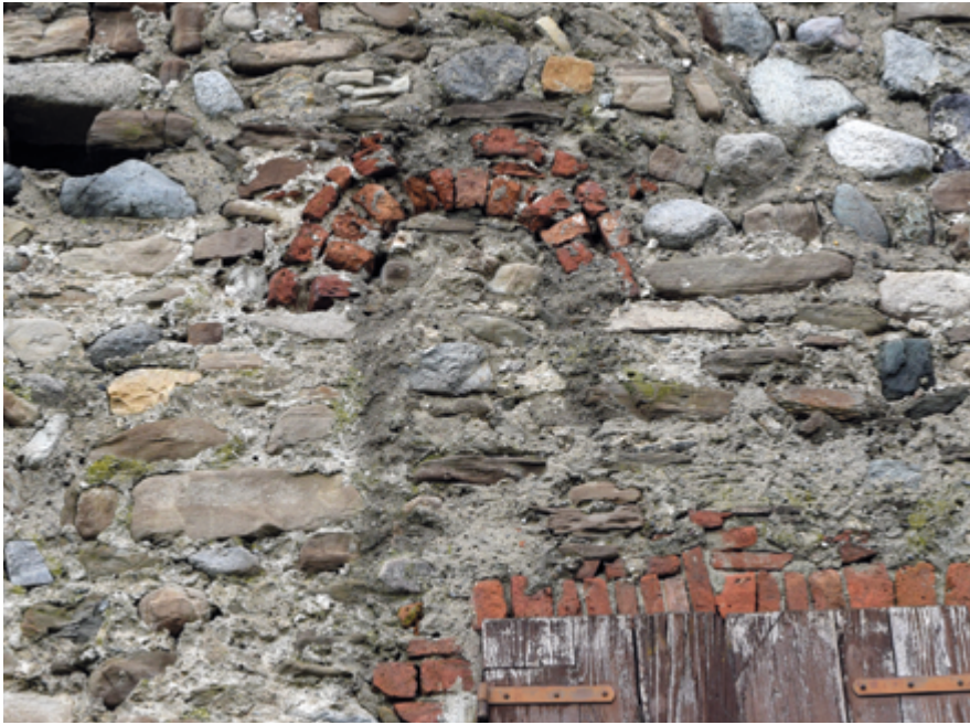
Figura 9 Monofora con ghiera in laterizio (US 566) lungo il prospetto W
