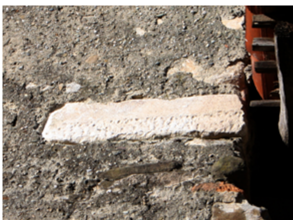
Figura 4 Porzione di cornice nel perimetrale est della cascina di Capiate
