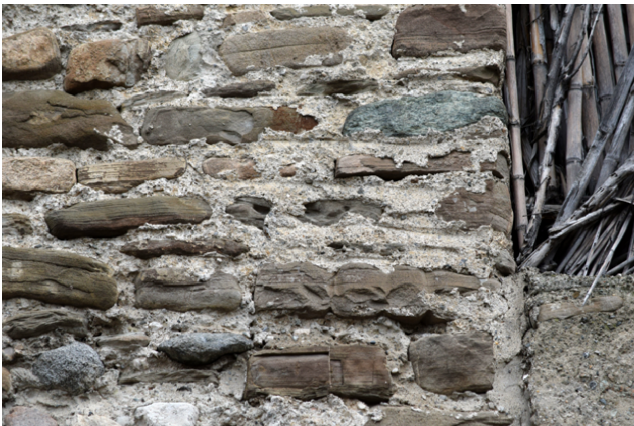
Figura 24 Palazzetto, prospetto E, angolo destro. Tracce di lisciatura della malta
