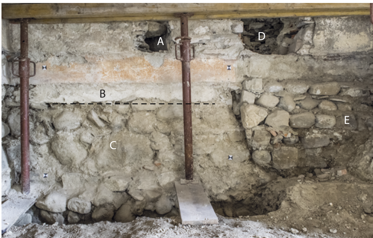
Figura 61 Absidiola N (lettera A), resti di intonaco con 'risvolto' che indica la quota del pavimento del presbiterio (B) e fondazione della chiesa medievale (C); sulla destra, l'abside maggiore (D), e la fondazione del muro moderno (E)
