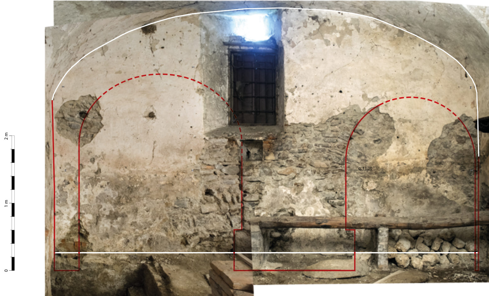
Figura 19 Palazzetto, ambiente al piano terra, parete W Fotoraddrizzamento e ricostruzione grafica delle archeggiature
