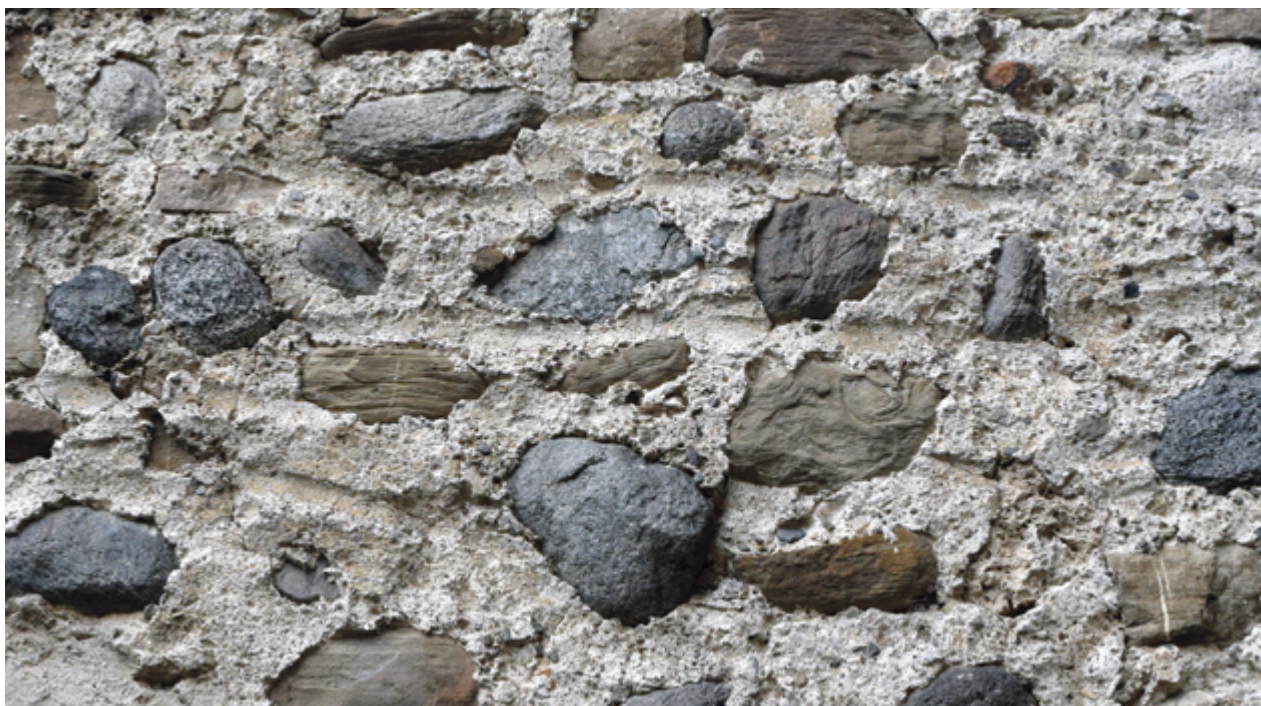
Figura 23 Palazzetto, lato S. Fase II, particolare delle lisciature della malta
