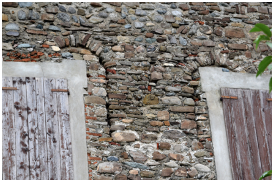
Figura 26 Palazzetto, prospetto W Finestre US 546 e 547
