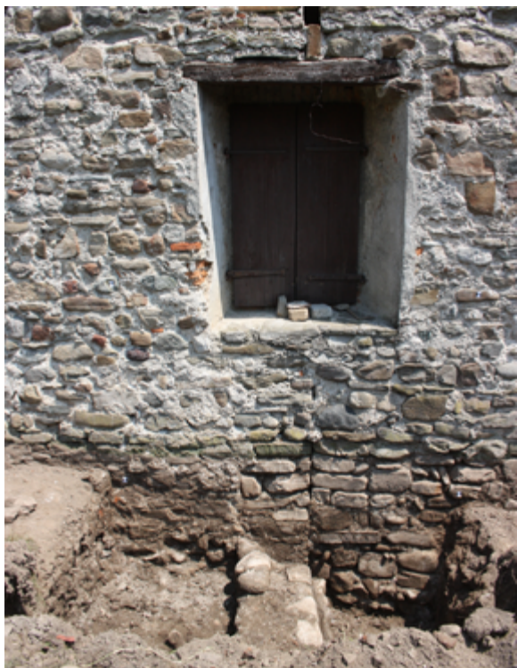
Figura 19 Particolare del muro ad angolo su cui si imposta il perimetrale ovest del Palazzo
