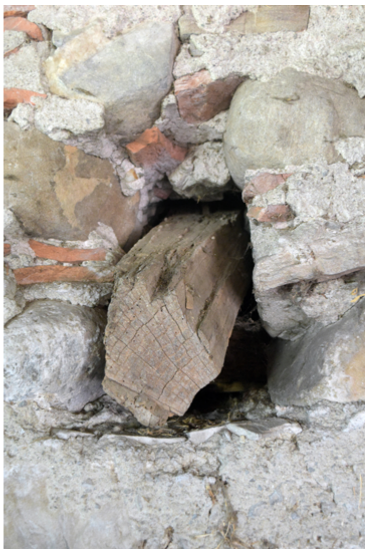
Figura 75 Dettaglio del travetto inglobato nella muratura
