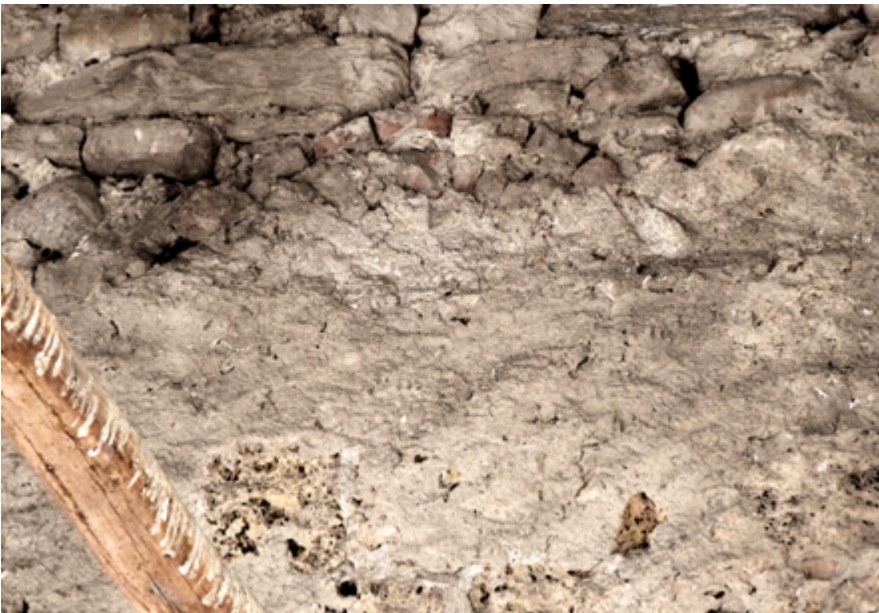
Figura 11 Resti della monofora con ghiera in laterizio (US 572) lungo il prospetto S
