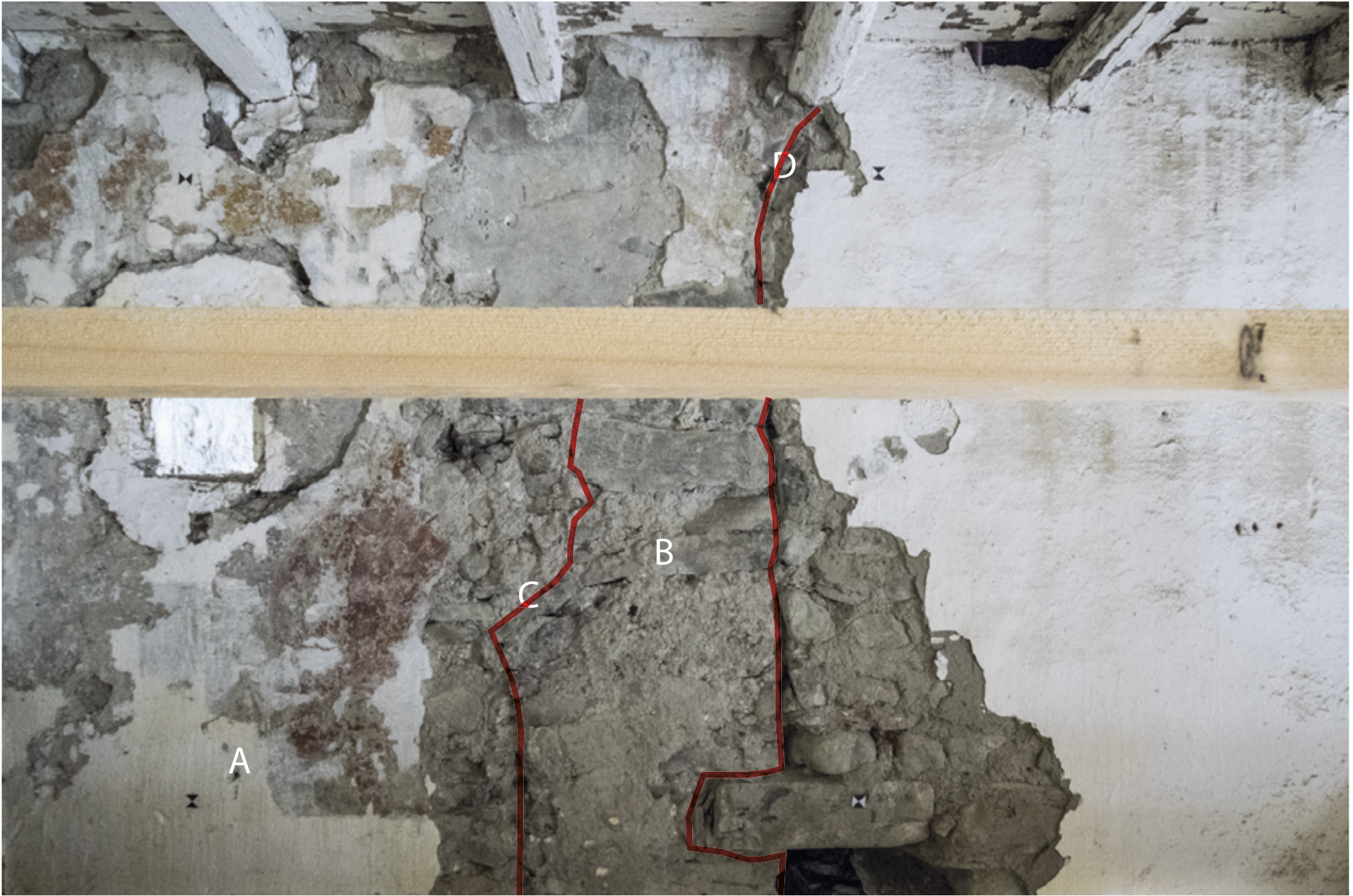
Figura 59 Abside. Tamponamento dell'absidiola N (lettera A); setto divisorio tra abside maggiore e absidiola N (B); imposta dell'arco dell'absidiola N (C); imposta del catino absidale maggiore (D)
