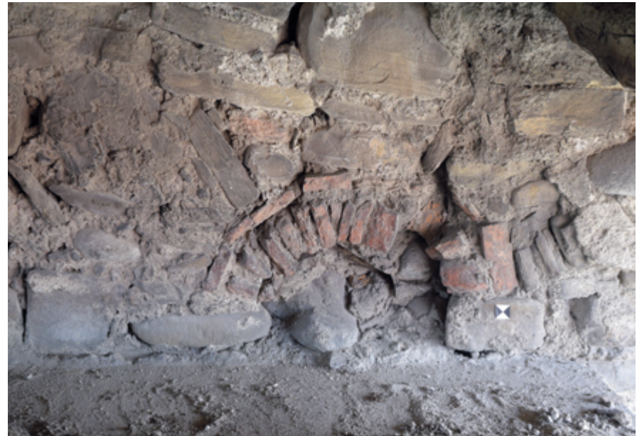
Figura 12 Monofora con ghiera in laterizio (US 573) lungo il prospetto E
