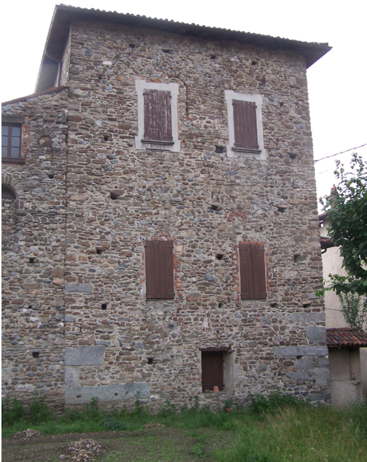
Figura 2 Elementi architettonici di recupero nel Palazzo
