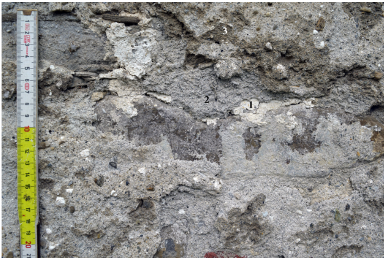
Figura 56 - Abside, dettaglio della sequenza degli intonaci
