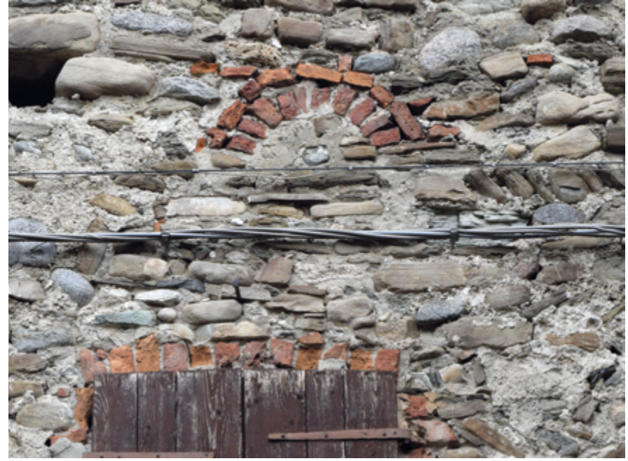
Figura 10 Monofora con ghiera in laterizio (US 554) lungo il prospetto S
