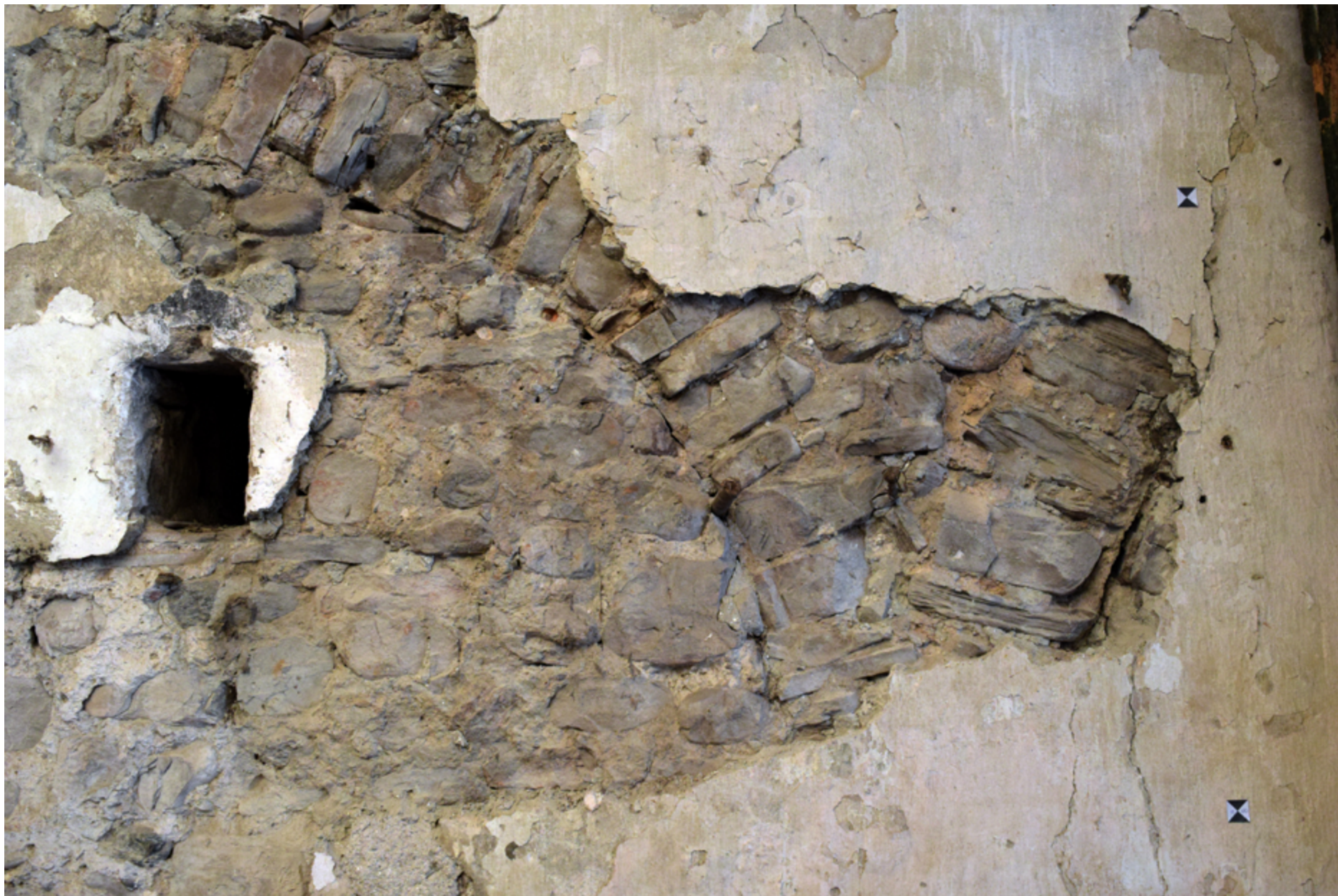
Figura 21 Palazzetto, ambiente al piano terra, parete N Particolare dell'archeggiatura (si noti l'intonaco nell'infradosso)
