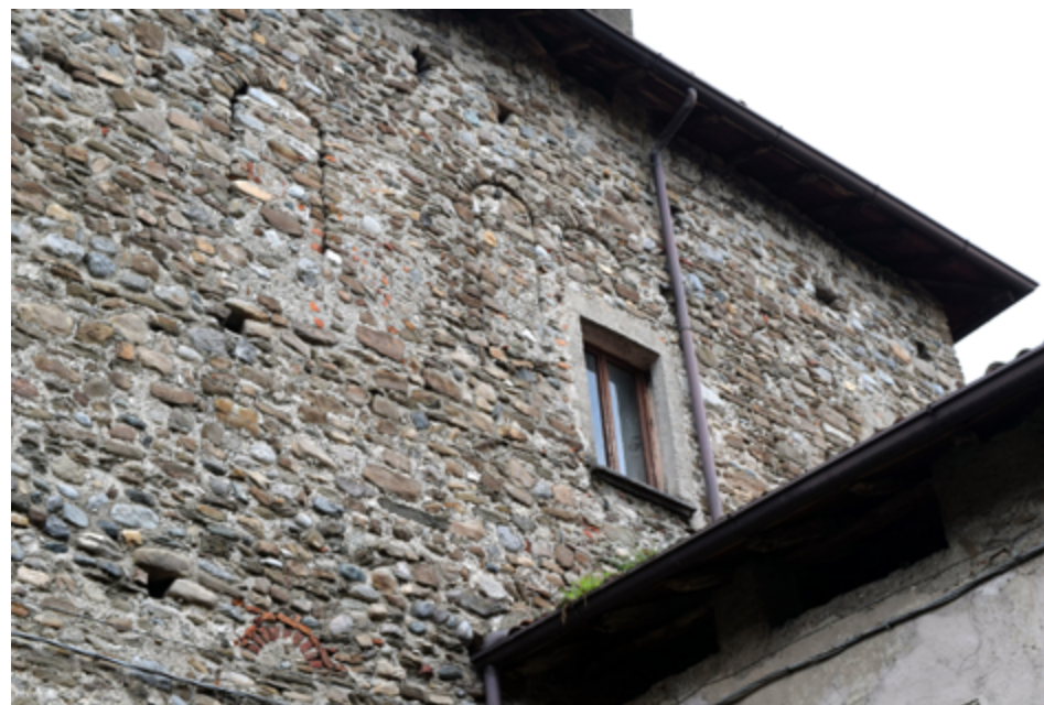
Figura 27 Palazzetto, prospetto S Finestre US 549, 550 e 551
